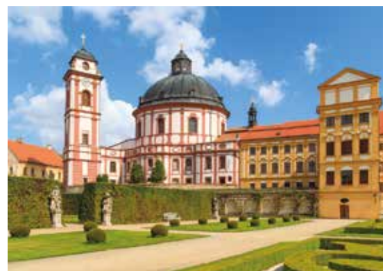
XILIX GEL FONGI+ byl použit k sanaci dřevěné klenby a krovu chrámu Sv. Markéty v Jaroměřicích nad Rokytnou
