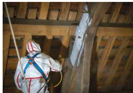
Práce s přípravkem XILIX GEL FONGI+. Po vsáknutí gelu bílá barva zmizí a nezanechá viditelné stopy.
