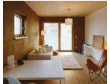
Použití hliněných omítek v novostavbě
