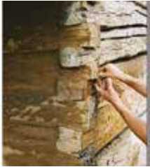
Naše hliněná směs se používá také ke spárování roubenek
