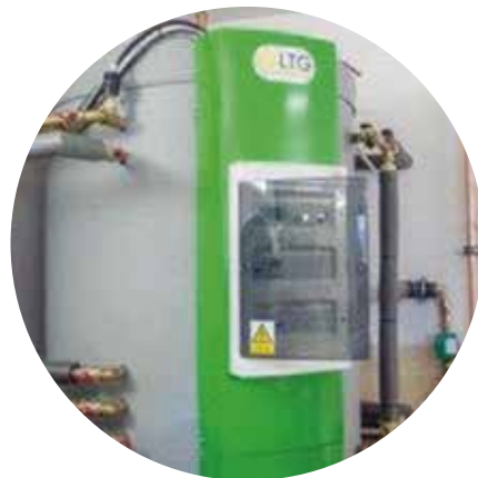
Nádrže, tepelná čerpadla
