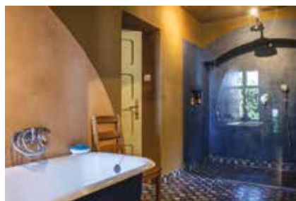
Marocký štuk + hliněná omítka + cihelná (terakotová dlažba) v koupelně
