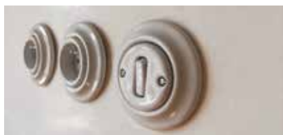
Keramické vypínače na podkladu z marockého štuk. Marocký štuk je lesklá minerální omítka určená pro vodotěsné povrchy.
